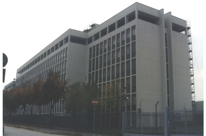
AD INTERVENTO ULTIMATO
