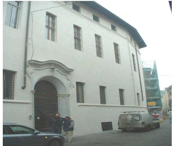
COMUNE DI LODI - restauro ex fabbricato F. Gaffurio
